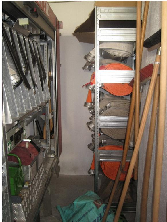
Das Gerätehaus kann nicht beheizt werden. Nach der DIN 14092-1 sind Fahrzeughallen auf mind. 7 °C zu erwärmen. Spindräume / Umkleiden sind auf mind. 22 °C beheizbar auszuführen. Dies dient u.a. dazu, dass nasse Einsatzkleidung schnell trocknet und beugt Schimmelbildung vor.
